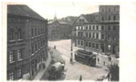
Fot. 8 Plac Tuwima, widoczny dawny hotel i browar.
