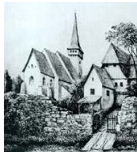
Fot. 11 Nieistniejący kościół pw. św. Michała
