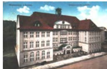
Fot. 4 Obecny „Energetyk” tuż po wybudowaniu.
